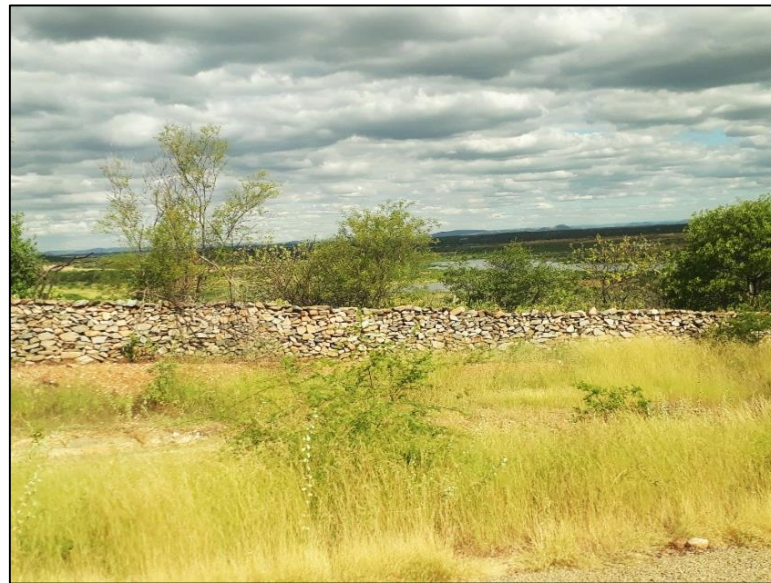
Figura 3 – Cerca de pedra no município de Caicó - RN Fonte: Registro da Pesquisa (2018).
