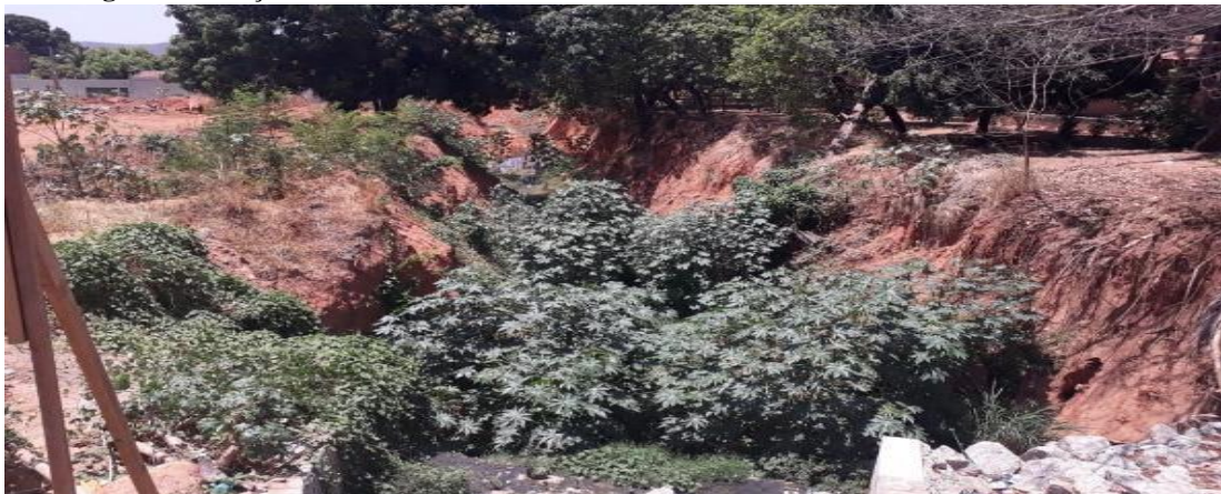
Figura 02: Voçoroca no bairro São José.
