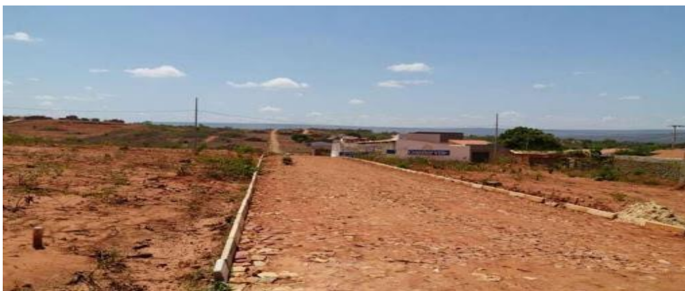
Figura 03: Construção de Loteamento.
