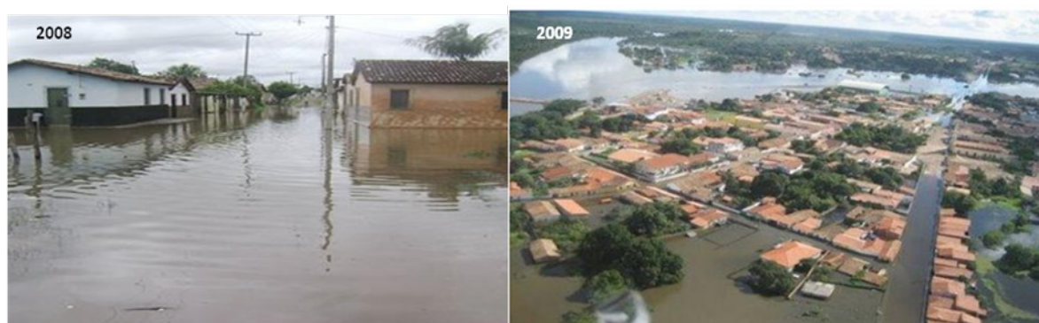
Figura 3: Inundações no bairro Batista de Amorim em 2008 e 2009. Fonte: Defesa Civil do Estado (2009)
