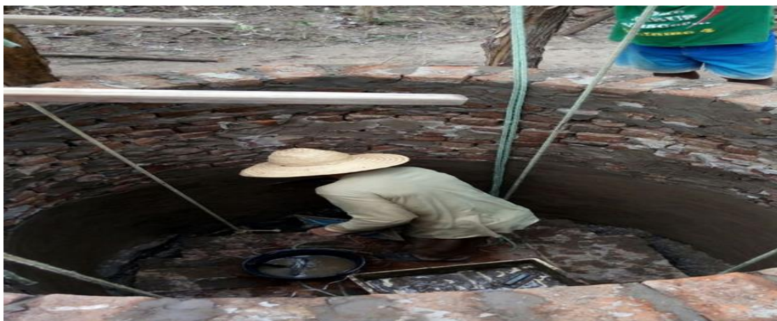
Figura 2: Escavação de poço nas proximidades do rio Berlingas em Várzea Grande-PI.
