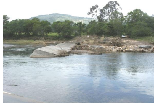
Figura 5- A primeira foto apresenta o curso do rio quando transportados os seixos, matações e blocos certamente da catástrofe ocorrida em 1974. A segunda foto apresenta a estrutura destruída sobre o Rio do Boi, o transporte de sedimentos, por saltação contribuiu bastante para danificar a base, (pé da ponte), pela força do atrito. Fonte: Graziela Bini, 2009.
