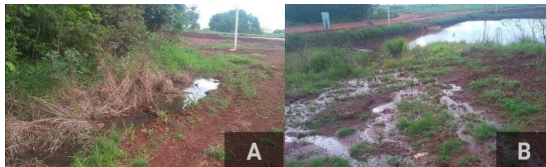
Figura 3 – Redirecionamento da nascente por meio de uma estrada. Em A identifica-se, ação antrópica com o processo de implantação de uma estrada que bloqueia o curso natural da água. Em B, redirecionamento do fluxo superficial devido a obstrução do curso natural, acarretando como consequência processos erosivos.
