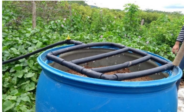
Figura 1 – Sumidouro realizando a filtragem da água.
