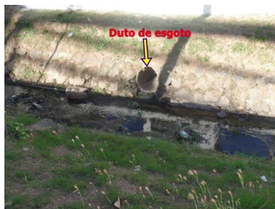
Figura 2 – Problemas ambientais no rio dos Seixos: (a) Canteiros paisagísticos, canalização e áreas impermeabilizadas no Trecho 1; (b) Duto de esgoto no Trecho 2 Fonte: os Autores (2018)
