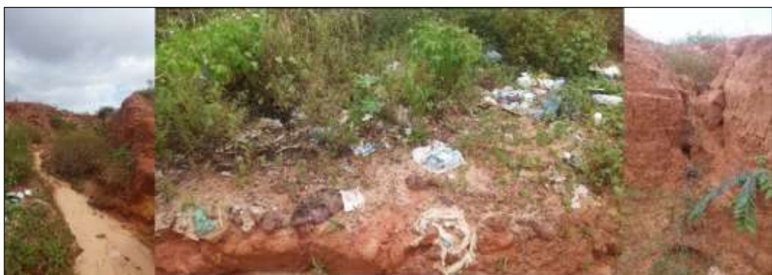
Figura 2 – Feição Erosiva ponto 1
