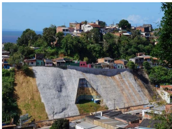
Figura 3 . Obra de contenção concluída (2017)
