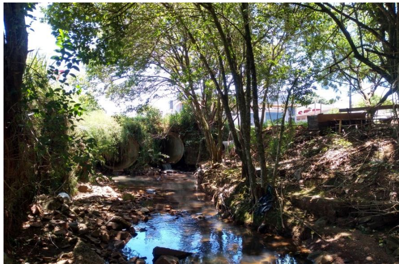
Figura 06. Canalizações de canais fluviais no centro de Laranjeiras do Sul-Pr.
