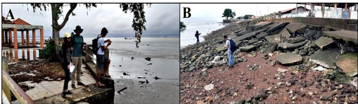
Figura 2 – Trabalho de campo realizado para a recuperação de dados primários. Fonte: os autores. Legenda: A – Observação de área afetada no bairro Perpetuo Socorro; B – Análise da estrutura do muro de contenção da orla do bairro Jandiá.
