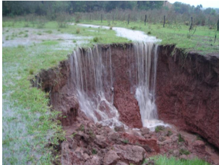
Figura 6 - Erosão por “efeito cachoeira” e solapamento de talude da voçoroca, em área de pastagem.
