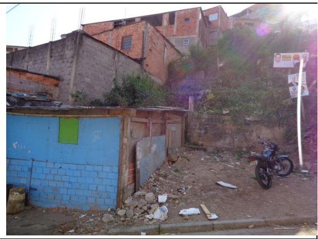
Figura 2b - mesmo setor, após intervenções (2014), onde ocorreu remoção de residências e uma ocupação posterior. Detalhe para o baixo padrão construtivo dos domicílios e o talude de corte
