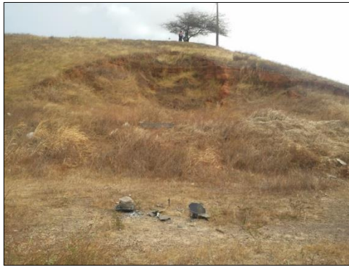
Figura 2: voçoroca Castelão Fonte : Autores, 2016
