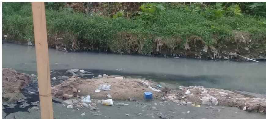
Fotografia 1: Trecho bastante assoreado no bairro de Linha do Tiro, Zona Norte do Recife, 2018.
