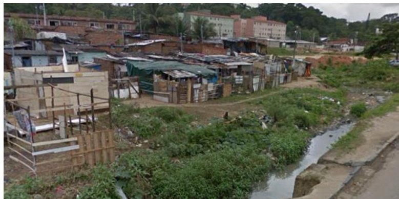
Figura 5 - Edificações construídas na calha do rio Morno no bairro de Linha do Tiro, Recife. Fonte: Google Earth.
