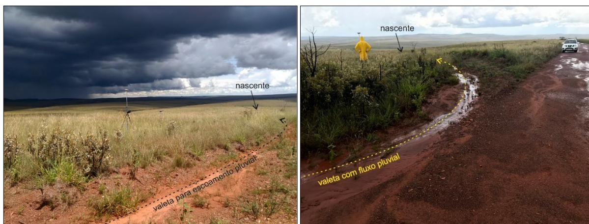
Figura 3 – a) Disposição da valeta para escoamento pluvial em relação à nascente com a aproximação da precipitação; b) valeta de escoamento com fluxo direcionando-se para a nascente.
