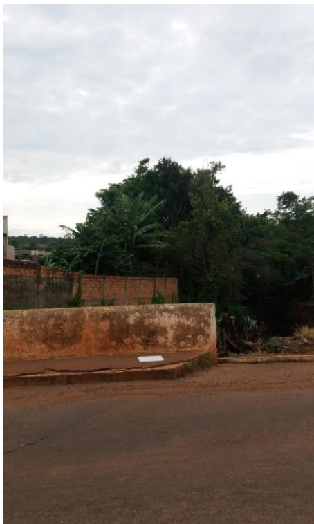
Figura 4 - Área construída em APP
