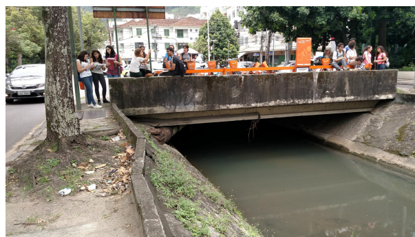
Figura 2: Trecho canalizado no baixo curso do rio dos Macacos. (Foto: Gabriel Abreu, 2018)
