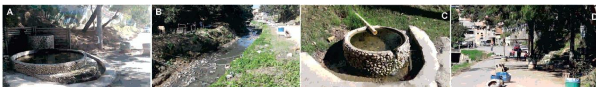
Figura 3 – Nascente no bairro Jardim Felicidade. A e C: Intervenção para revitalização da nascente B: córrego Tamboril/Fazenda Velha; D: Rua Fazenda Velha. Fotos dos autores; 22/05/2018.
