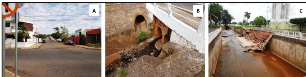
Figura 4 – A) Vista da área que encontra-se a nascente do córrego Biriguizinho. B) Local da saída d'água do córrego. C) Margem cedida. Fotos: Alessandra Fagundes (2017 e 2018).
